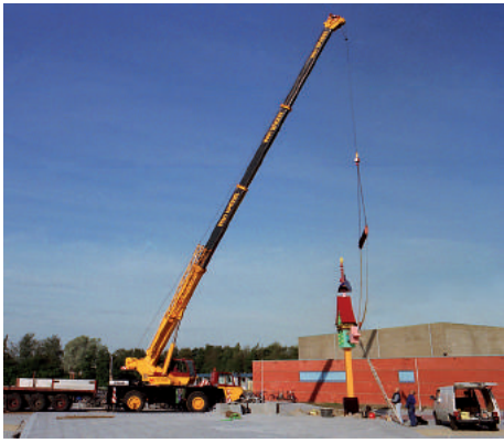
Rijplaten, 200 meter, waren er nodig om "Perge" te plaatsen.
