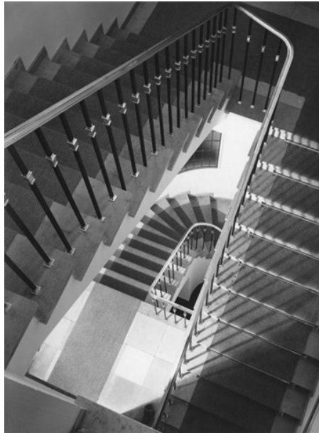
Trappenhuis, Rheinisch-Westfälische Bank (Karl Hugo Schmölz, 1952)
