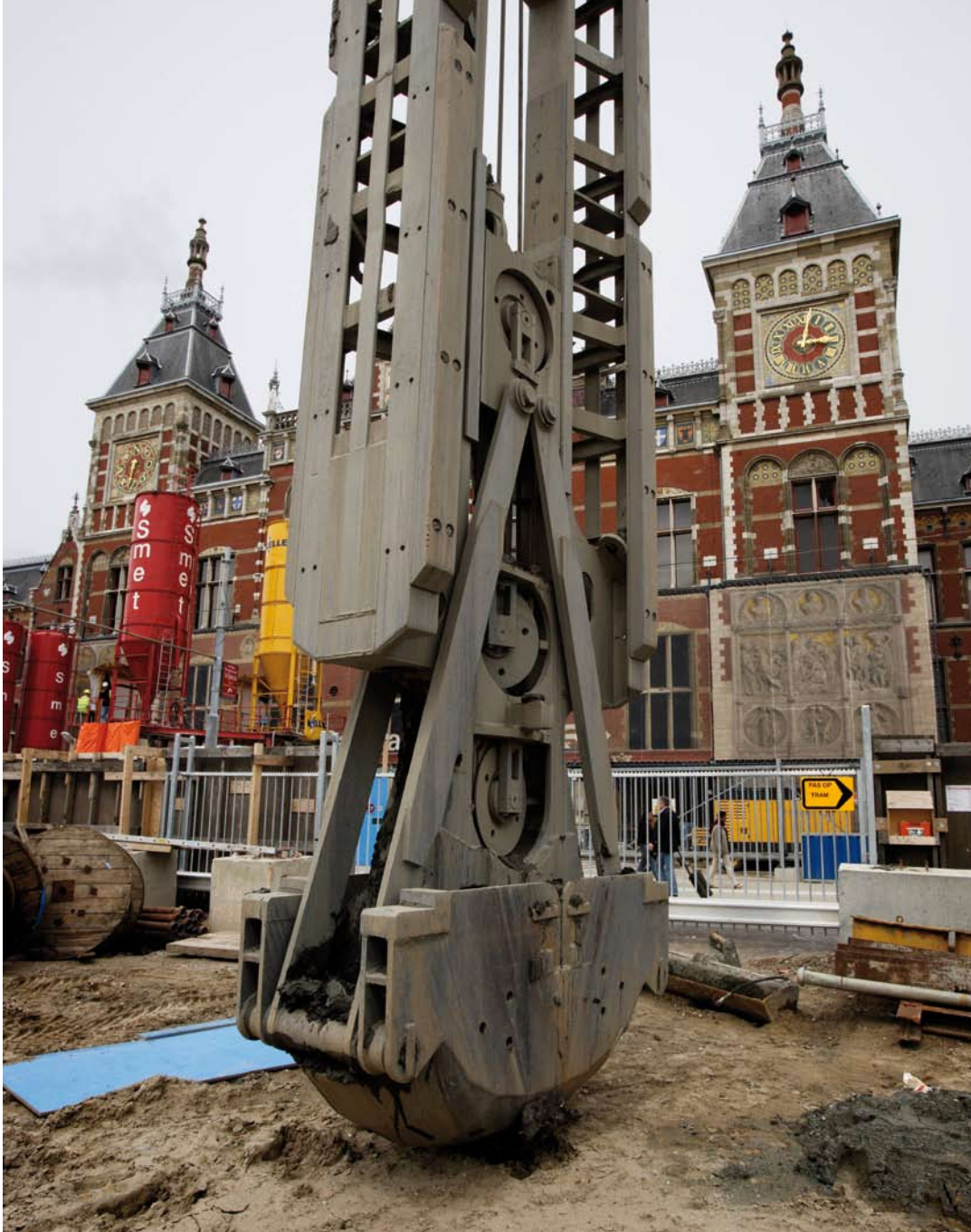
De gripper van een diepwandgraafmachine op het Stationsplein van het Centraal Station. Eind augustus werden de laatste diepwandpanelen en boorpalen gemaakt. Hiermee werd de gehele bouwputwand op het Voorplein gerealiseerd.
