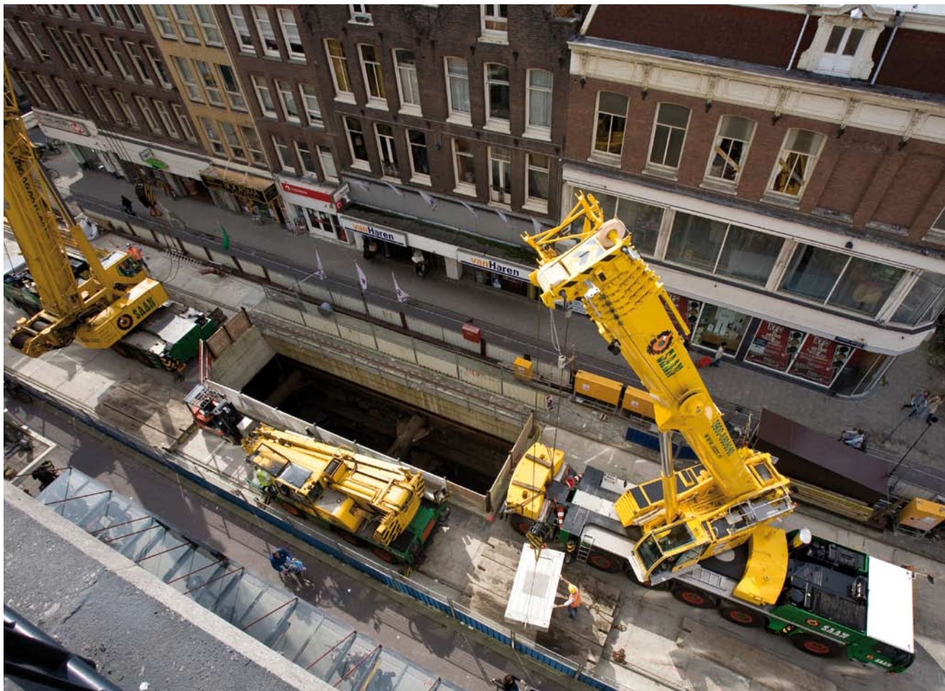
De mobiele 40 tons compactkraan wordt door twee 100 tons kranen het station ingehesen. De compactkraan gaat in station Ceintuurbaan de sluisdeuren van de materiaalsluis op hun plaats brengen.
