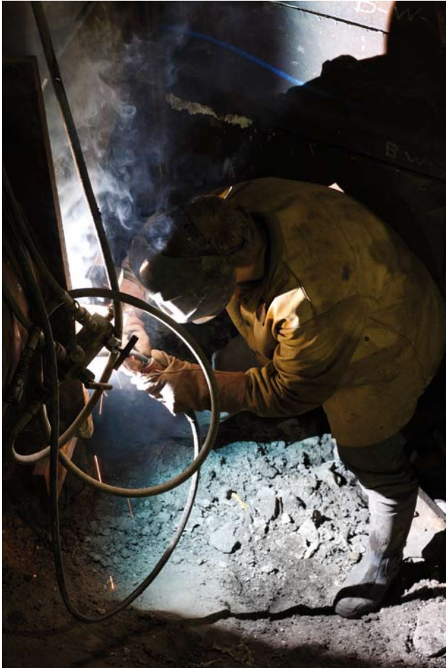
Een lasser aan het werk in station Rokin.
