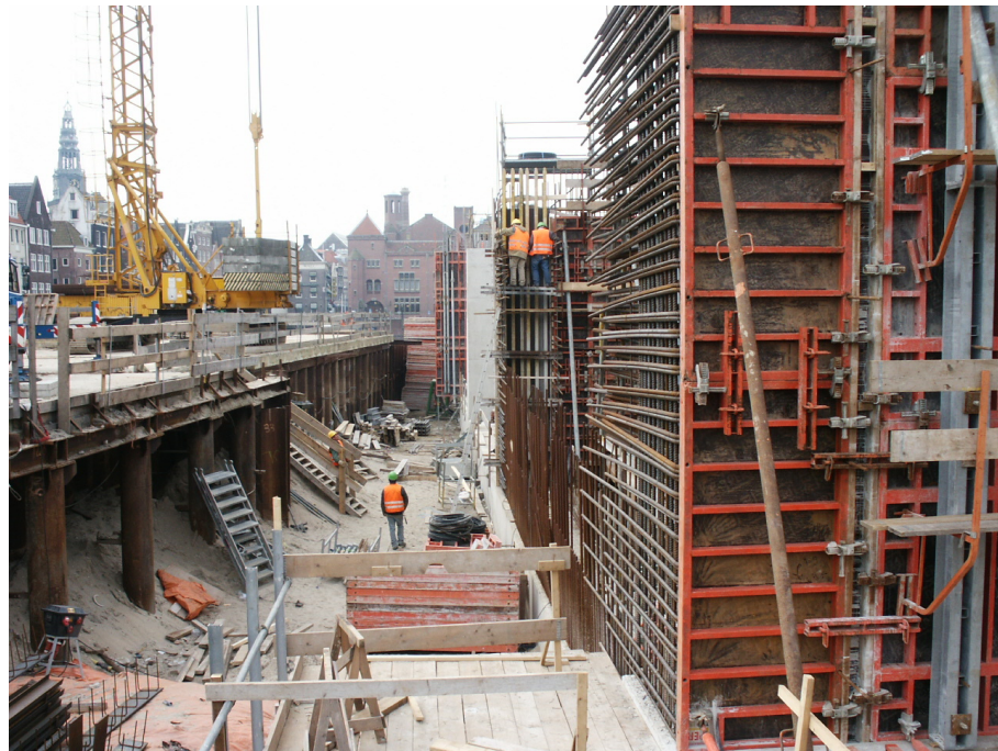
Afbeelding 1: de bouw van het startcaisson onder het Damrak had veel voeten in de aarde. Foto TransTec.
