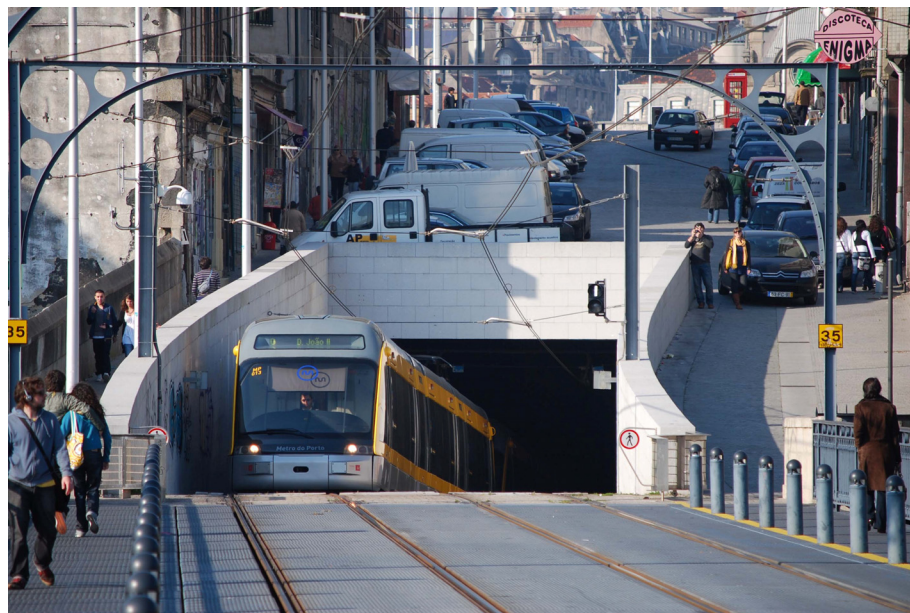
Afbeelding 8: de 'metro do Porto' in Portugal is een sneltramnet dat gebruik maakt van vrije trambanen, tramtunnels en straattrajecten. Soms ligt er midden in de stad een tunnelinrit. Foto TransTec.
