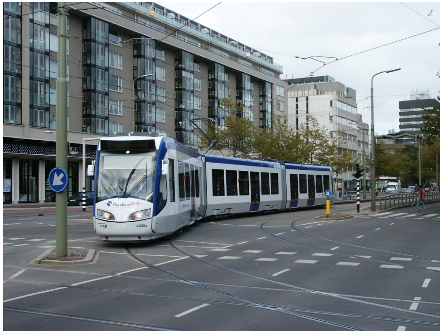
Afbeelding 14: het Haagse RandstadRail maakt in het centrum gebruik van een korte tramtunnel. In Den Haag wordt vervolgens verder gereden over (meestal) vrije trambanen in de straat. De trams zijn ruim 37 meter lang en 2,65 meter breed. Foto TransTec.
