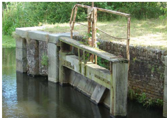
De 3e sluis is nog in originele staat.
