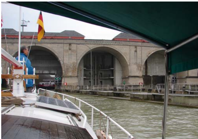
Sluis Anderten (de Hindenburgsluis bij Hannover)
