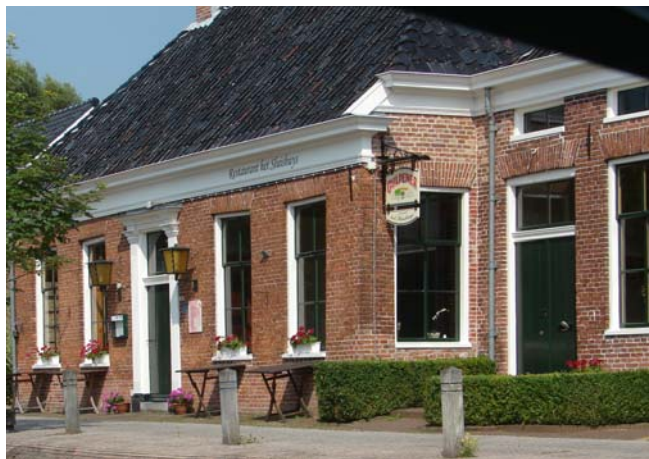
Restaurant "Het Sluishuis" bij de middenluis.
