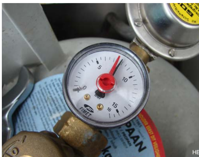
Na 5 minuten wijst de manometer nog 7,9 bar aan. Een goede reden om eens op onderzoek uit te gaan en een en ander af te soppen.
