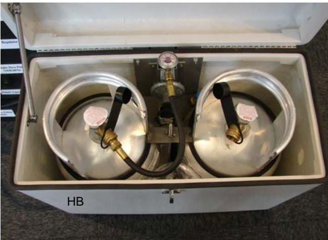
Engelse installatie met het reduceer aan de wand en uitgevoerd met een manometer.
