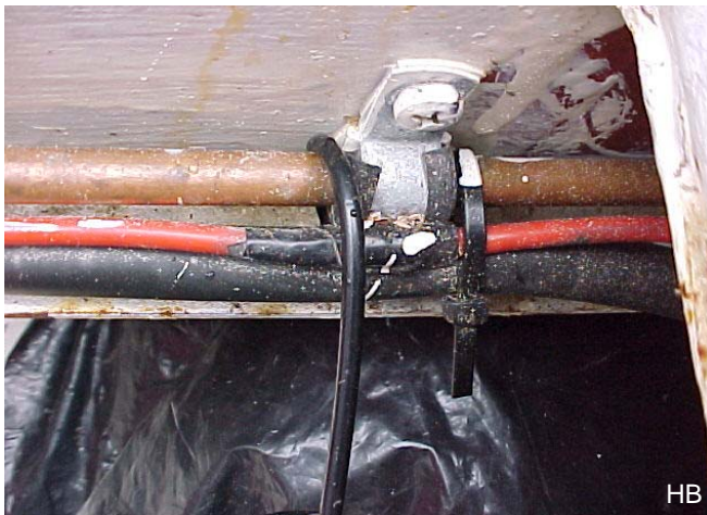
Gasleiding is geen kapstok.
