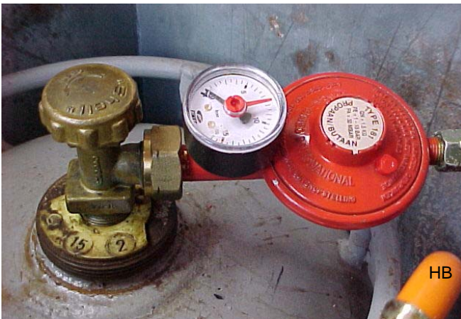
Hier is het bedieningsbordje te zien. Er is alle kans op een lekkage daar de slang zonder slangpilaar over de pijp is geschoven!
