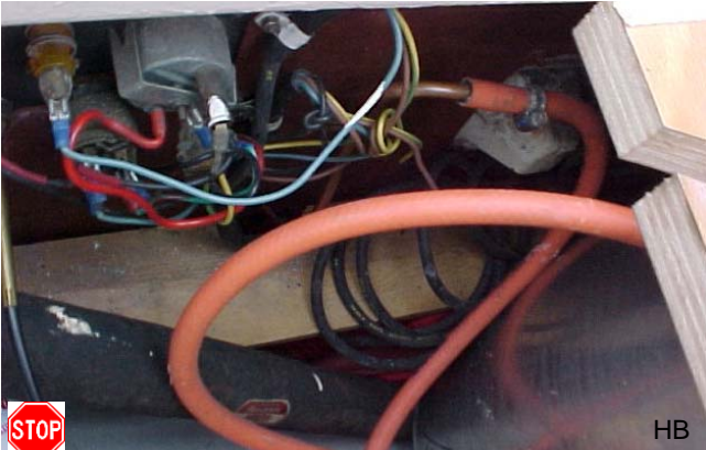
Hier is het bedieningsbordje te zien. Er is alle kans op een lekkage daar de slang zonder slangpilaar over de pijp is geschoven!
