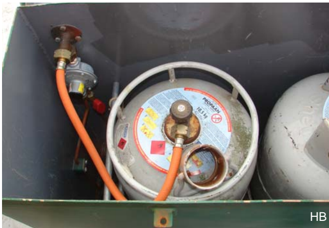
Het reduceerventiel zit aan de wand. Het is jammer dat de hoofdschakelaar zover weg zit en de manometer ontbreekt.
