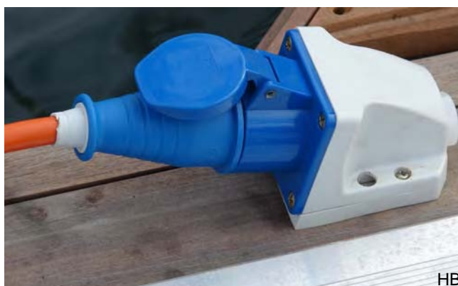
Een CEE contactstop op de steiger
