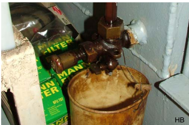
Een veel voorkomend voorbeeld is de afdichting van het peilglas. Hoe vaak zie je er geen emmertje onder hangen terwijl het voor 20 cent weer dicht is! Let op: onder de zeskante moer zit ook een rubberen ring.
