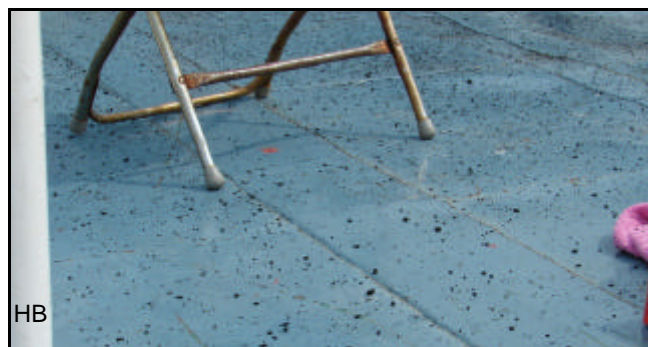
Dit "fijnstof" is redelijk ongevaarlijk daar het grote vlokken zijn. Je kunt er altijd nog zwarte verf mee maken of mengen door de epoxy om zodoende rubbernaden mee te imiteren.
