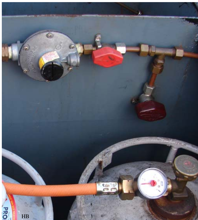
Een testmanometer en test-aansluiting is aanwezig, alleen de afblaasleiding ontbreekt.
