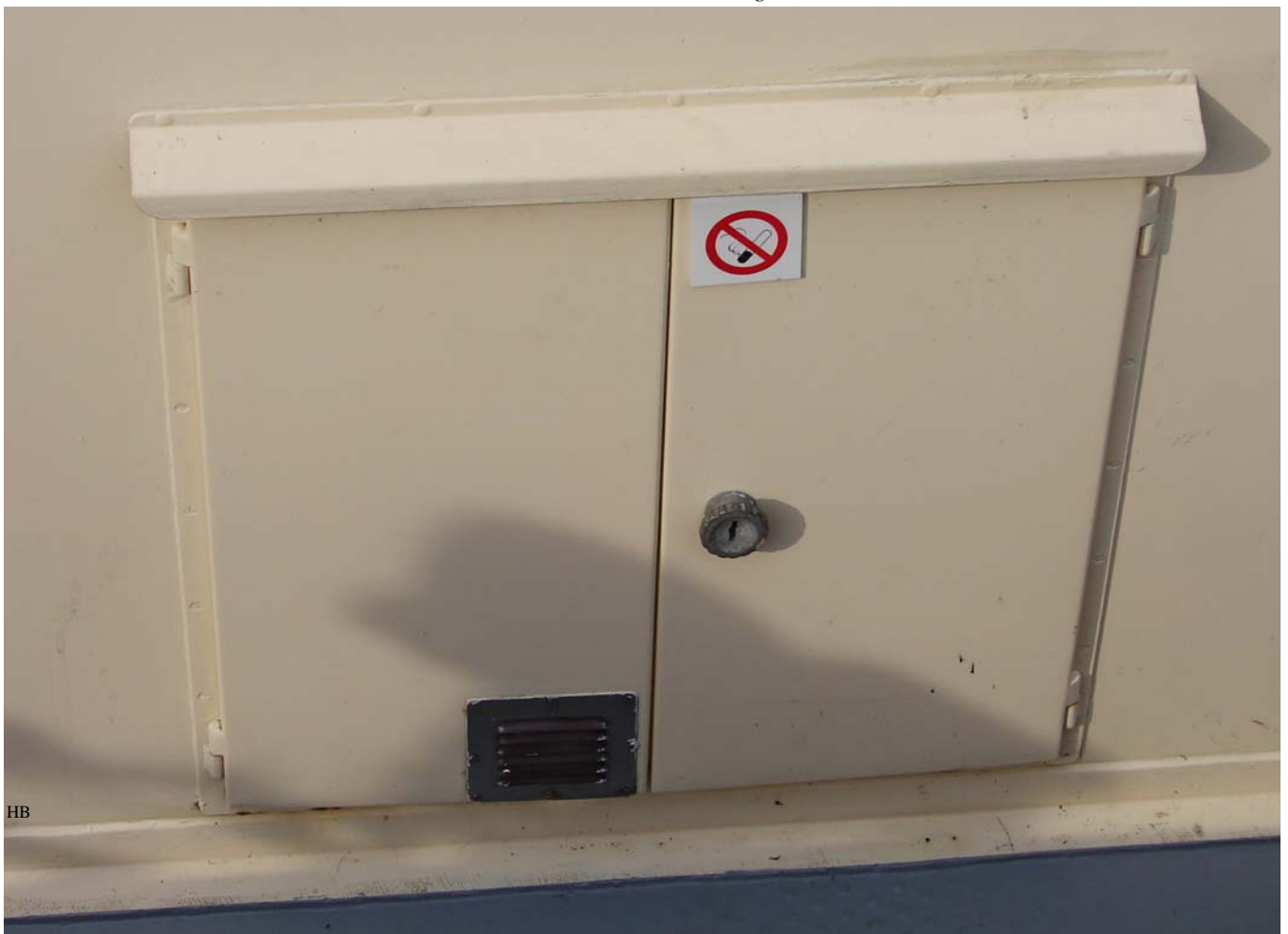
Een gaskast aan de buitenkant van het schip sluit elk risico uit.
