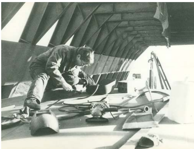
De zeetjalk Linqwenda in Velsen-Noord wordt voorzien van nieuwe luikhoofden en dekken (EC)
