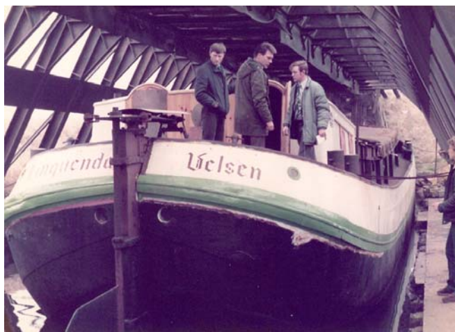
Boven de ligplaats van de Linguenda in Velsen Noord is hier nog een stalen constructie te zien waarover spoorrails liepen. V.l.n.r. Theo Hoogmoed, Wim Hilbers, onbekend en een zoon van Wim Hilbers (EC)
