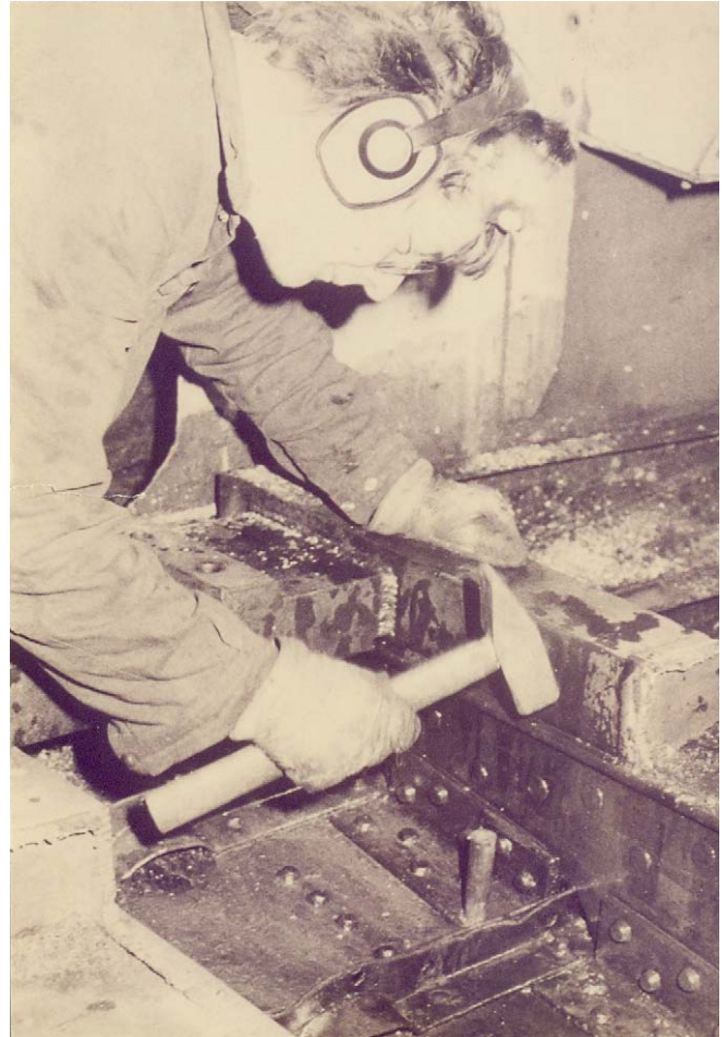
Joep Brassier hamert een houten pen in het gat van de verdwenen klinknagel (EC)
