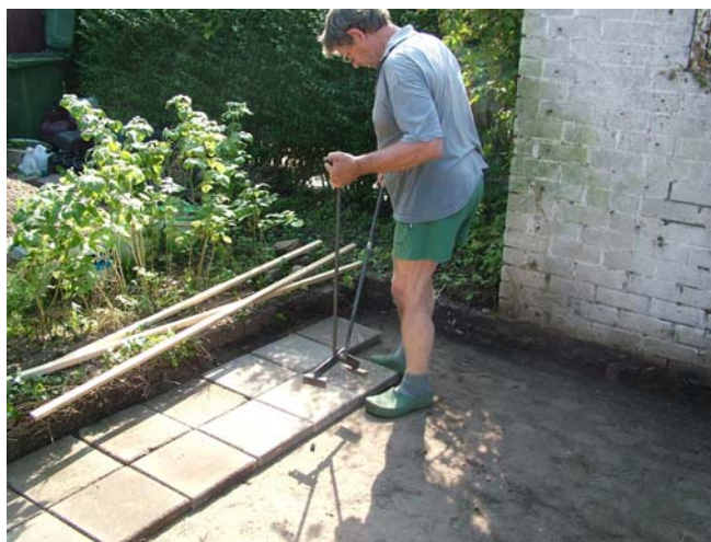
Van tegels leggen krijg je maar pijn in je rug. Dus maak je een zelf een tang om ze gemakkelijk op te tillen en te plaatsen, 4 september 2005 (EC)
