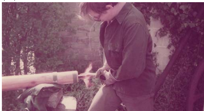
Smeedwerk voor de bokkepoten van Jaap Duijvetter wordt warm ingebracht waardoor het hout conserveert (EC)
