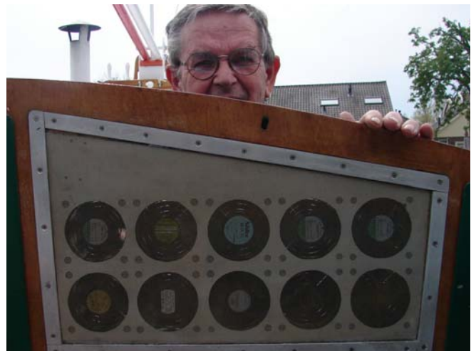
De definitieve oplossing met 10 oude ventilatoren van oude computers op 12 Volt. Heerlijk koel binnen! (EC)
