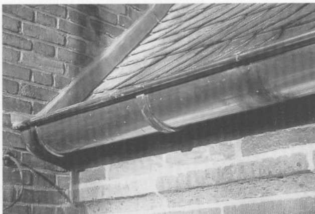
5. Een goed geconstrueerde mastgoot met zware koperen beugels 8 x 40 mm.
