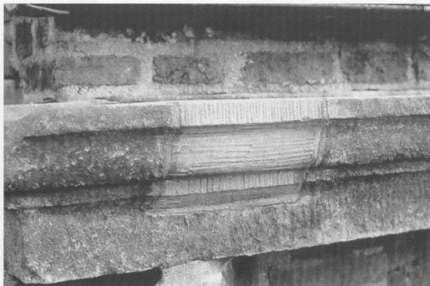
45. Bij restauratie aangeheelde en gehandhaafde 17de-eeuwse natuurstenen goot.
