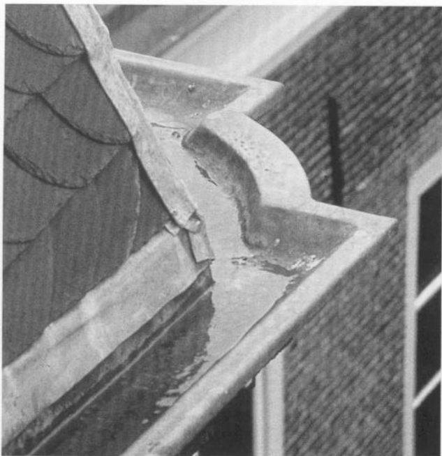
37. Lood is zeer geschikt voor speciale gootvormen. Het dient in profiel geklopt te worden door middel van drijven; zo weinig mogelijk solderen of lassen.
