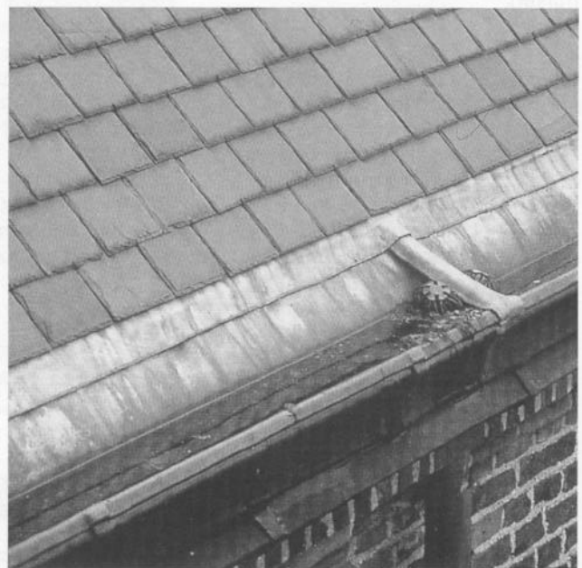
9. Een in lood geconstrueerde schampgoot heeft een geringe waterberging en bij verstoppingen loopt het water over het lood de muren in.
