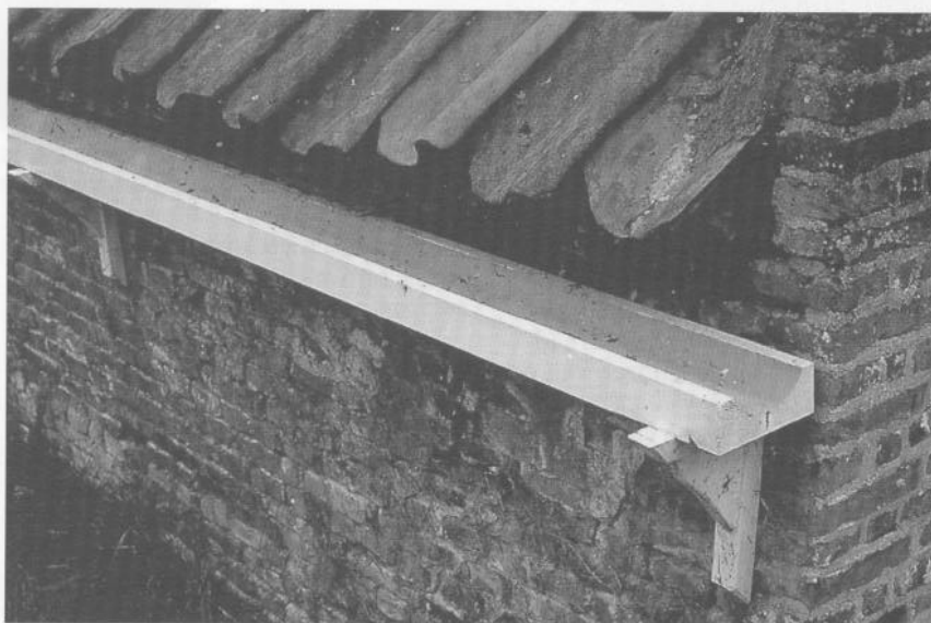
4. Een blokgoot op klampen aan een huisje in het Buitenmuseum in Enkhuizen.
