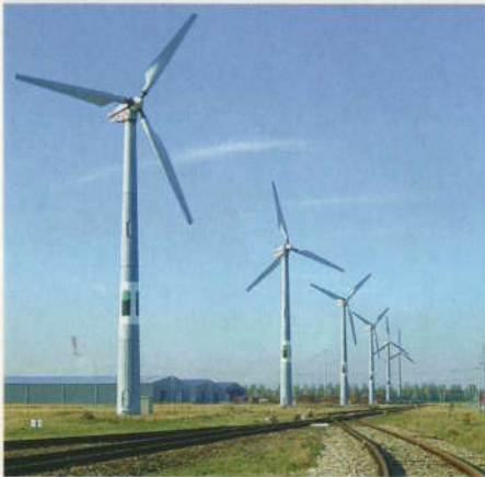
Ruimte voor windenergie is schaars. Stroken langs spoorlijnen kunnen goed worden benut, zoals hier in Vlissingen
