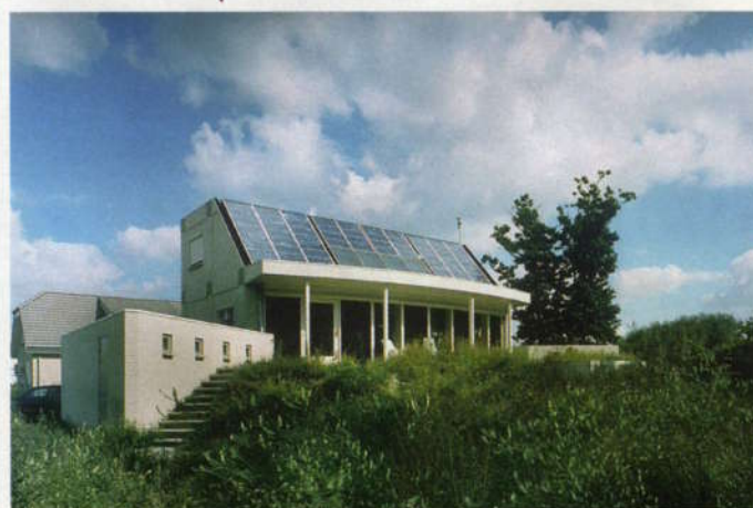
De 'all-electric' nul-energiewoning in Zandvoort is bedoeld als experiment met dakintegratie van zonnepanelen. Foto: Novem/Riesjard Schropp.
