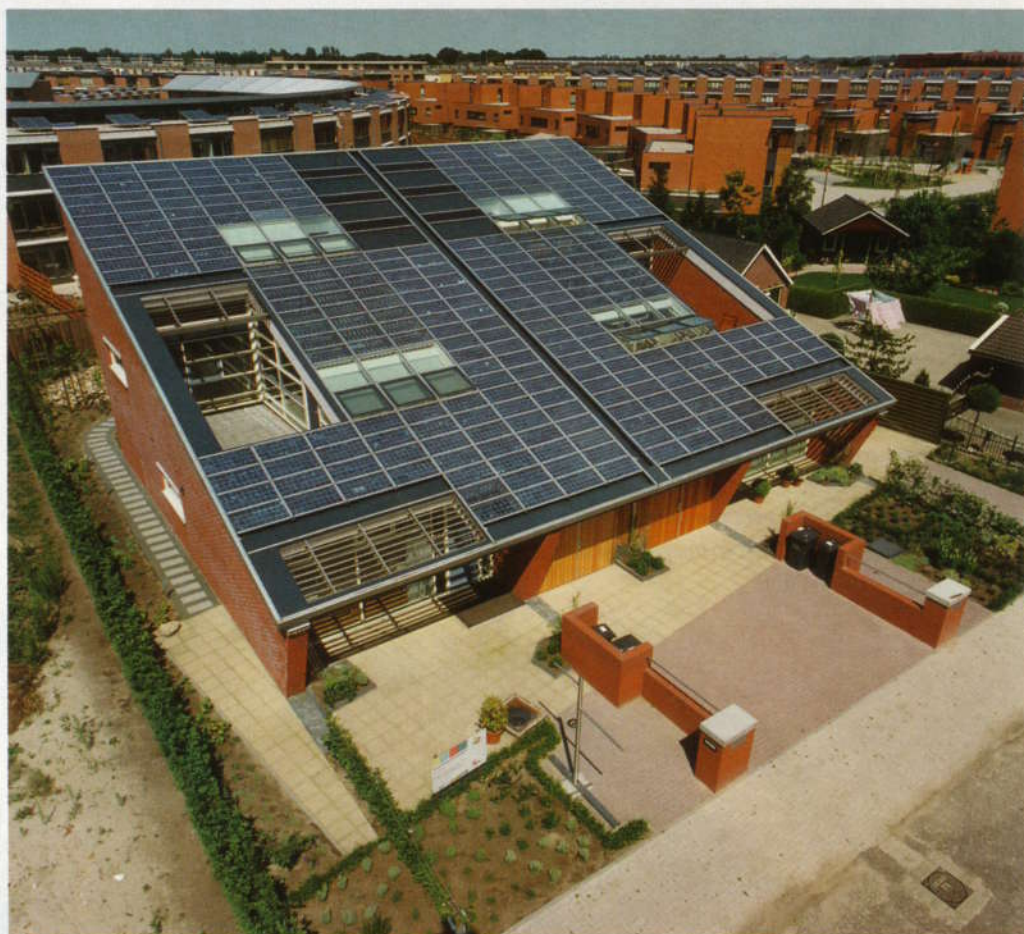
De energiebalanswoningen in Amersfoort, uitgerust met maar liefst 78 vierkante meter zonnepanelen voor de opwekking van elektriciteit, een zonneboiler en een warmtepomp die bodemwarmte benut. Foto: Jan van IJken
