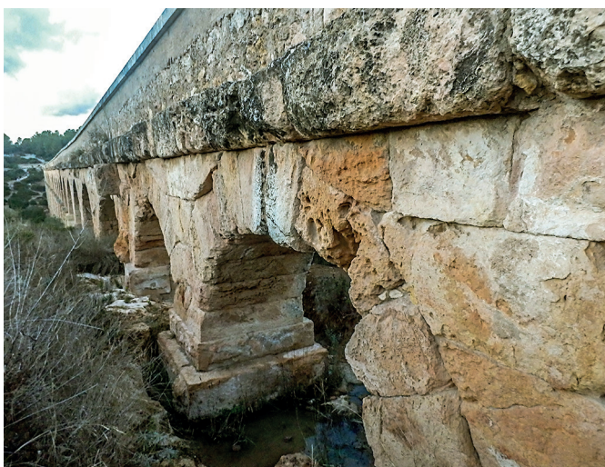
Afb. 10. 'El Pont del Diable' (ofwel Aqüeducte de les Ferreres, beide Catalaans), is een Romeins aquaduct even ten noorden van Tarragona. Het bouwwerk bestaat in het middendeel uit twee rijen met bogen (boven elkaar) en voorzagt de oude Romeinse stad Tarraco van water. Bezoekers kunnen via het aquaduct het dal oversteken. Het imposante monument maakt deel uit van het Archaeological Ensemble of Tarraco, Unesco Werelderfgoed sinds 2000.
