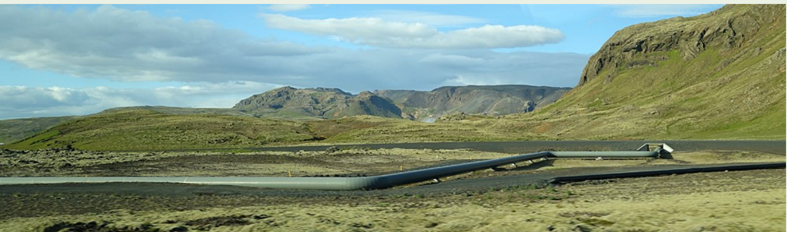
Pijpleidingen van Hellisheiði Power Station, zichtbaar vanaf de ringweg 1 tussen Reykjavík en Hveragerði. Foto: Annemieke van Roekel.
