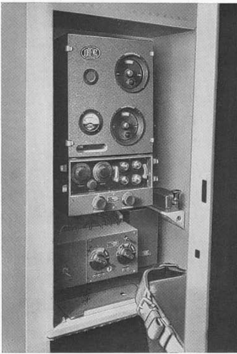
Abb. 12. 100 Watt Flugzeugfunkanlage, eingebaut in der Funkkabine einer »Junkers G 31«, 1928
