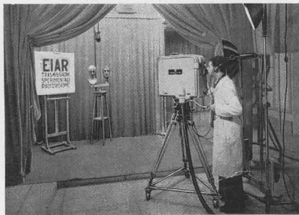
Abb. 6: Bühnen-Kamera der Fernseh Aktiengesellschaft im Studio der EIAR.
