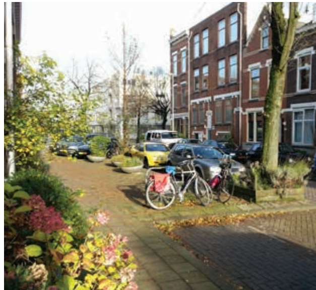
Geveltuinen zuidzijde Watergeusstraat
